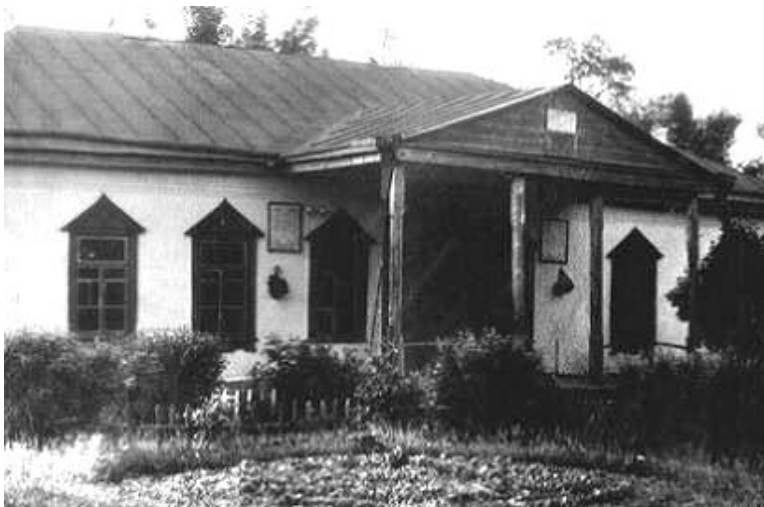
Будинок О. П. Дворянської. У цьому приміщенні була Хоцьківська школа до 1975 року
